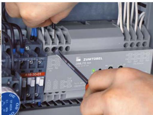
Alles, was der Installateur für den Einbau einer DIMLITE Lichtsteuerung an Werkzeugen braucht, ist ein Schraubendreher. Als Erstes wird das Basisgerät im Schaltschrank installiert ...
