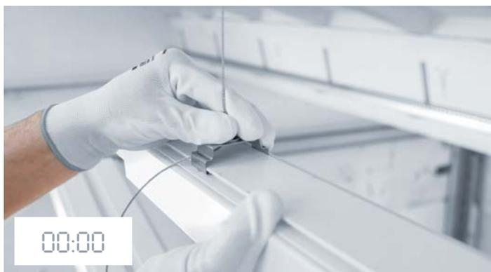
1 Tragschiene mit Clix-Feder an die Decke montieren oder abhängen.
