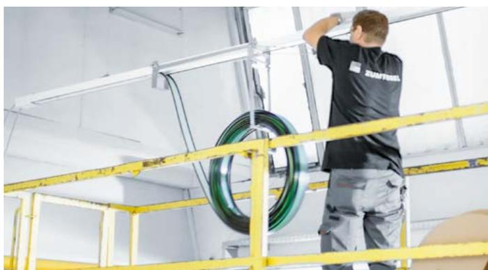
7 Dichtungsabdeckung mit dem Montagetool über die gesamte Länge des Lichtbands einstreifen.
